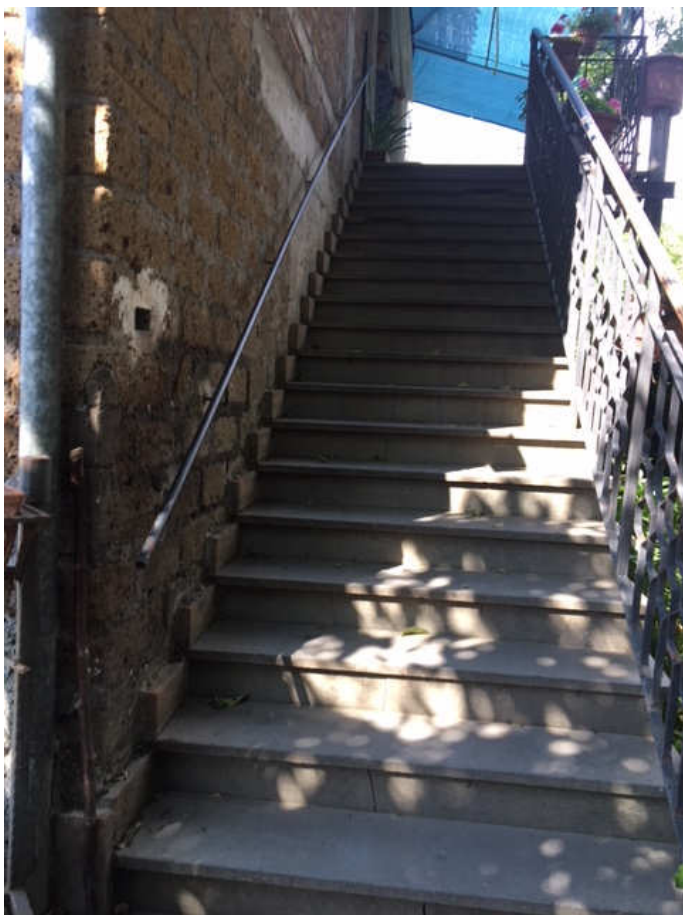
Foto n. 3 – Scala esterna di accesso all'appartamento P1
