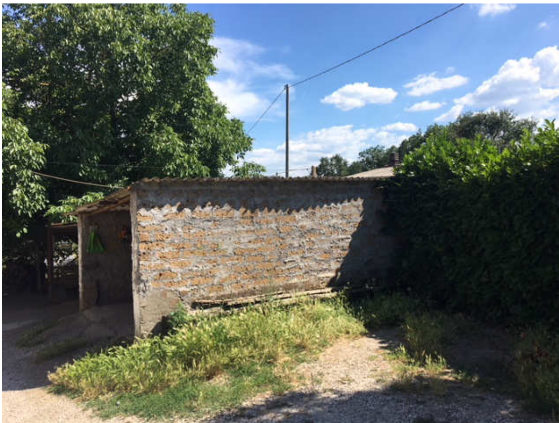
Foto n. 1 – Esterno rimessa attrezzi
