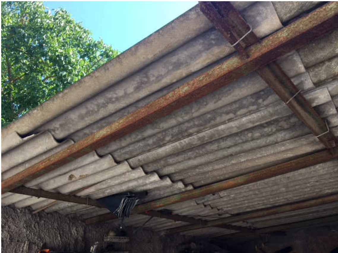
Foto n. 22 – Rimessa attrezzi - copertura
