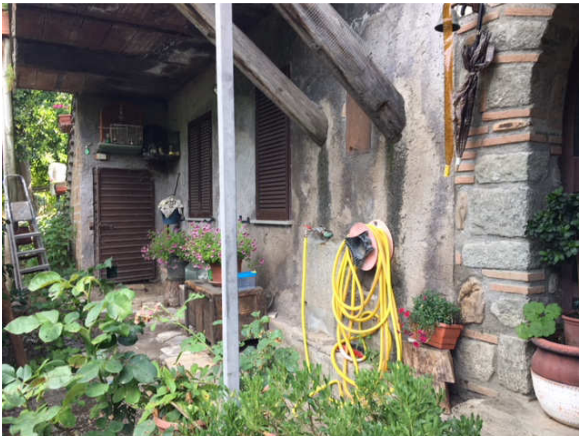
Foto n. 14 – Appartamento PT- esterno
