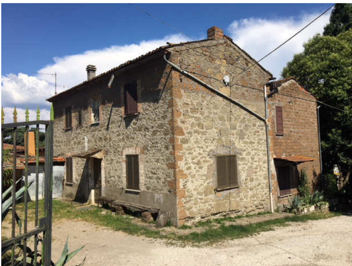
Foto n. 2 – esterno della zona residenziale
